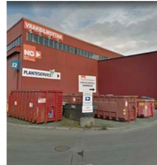
25. Lagerbygg. Ligger veldig sentralt til. Rives. Bruke kledning?
