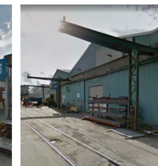
9. Stålkonstruksjon strekker seg nedover hele Transittgata
