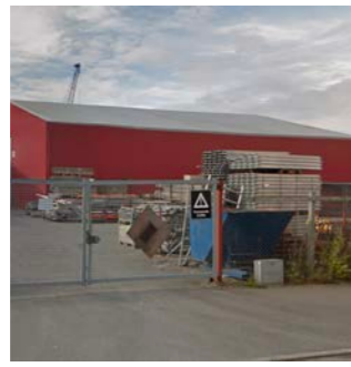
18. Lagerhall i grei stand. Rives. Bruke kledning?
