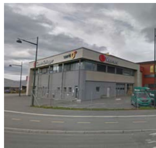
33. Værnes rørlegger. Få kvaliteter. Rives.
