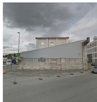
39. Betongkonstruksjonen må bevares. Mulig å transformere resten? Formen bør opprettholdes uansett.
