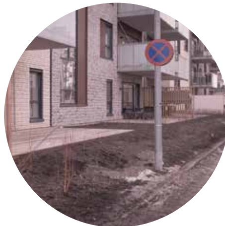
Vinduer med innsyn på gatenivå skaper oversiktlig og bidrar til opplevd trygghet.
