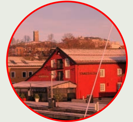
Tønsberg Brygge historiske fasader og irregulære bygningsstrukturer skaper høy lesbarhet.
